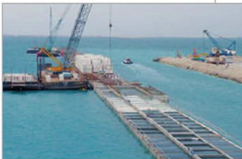
Figura 11 - Posa in opera dei cassoni cellulari in cemento armato presso il cantiere Nakilat.
