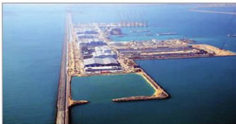
Figura 10 - Il cantiere per riparazioni navali di Nakilat, Qatar.
