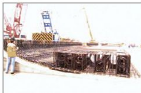
Figura 7 - Gabbia d'armatura con prevenzione catodica installata prima della colata in cantiere.
