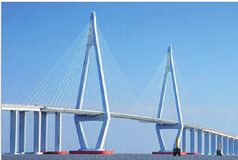
Figura 16 - Torri dello Hangzhou Bay Bridge.
