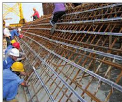
Figura 18 - Applicazione degli anodi con spaziatori di cemento per realizzare il sistema di prevenzione catodica dei piloni principali dello Xia-Zhang bridge.
