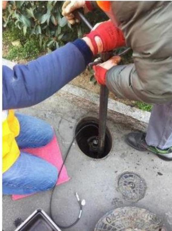
**Figura 11 – Fase di installazione idrofono su idrante**
