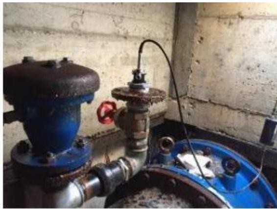
**Figura 10 – esempio di installazione idrofono su sfiato posto in cameretta**
